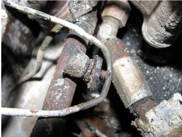
Foto 16: struttura filtro drenaggio benzina.
