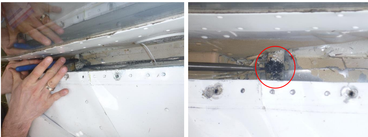
Slika 1.19. Otvaranje cijevi glavnog voda
