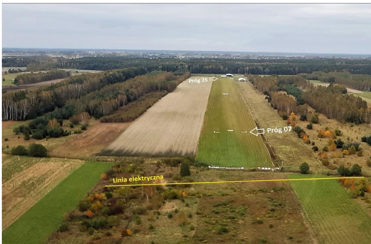
Rys. 1. Widok progu pasa 07 łądowniska Nieborów-Bobrowniki – [źródło: Internet]
